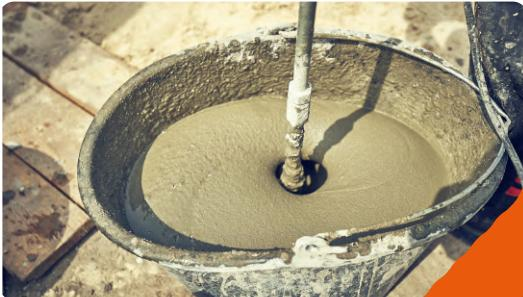
Mezcle el agua con la masa al menos durante 5 minutos para obtener una mezcla homogénea.
