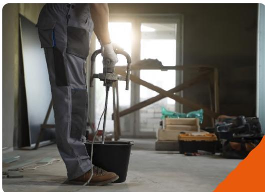
Puede utilizarse un vibrador o cualquier otra herramienta para mezclar, asegúrese de que estas estén limpias antes de usarse.
