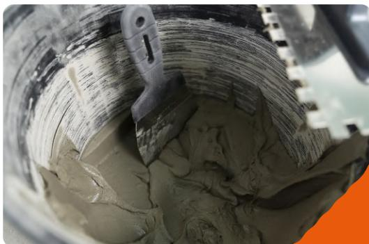
El recipiente a utilizar para para realizar la mezcla con el agua debe ser impermeable.
