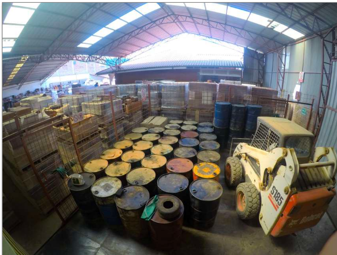
Anexo 34. Área de almacenamiento de los aceites minerales usados.
