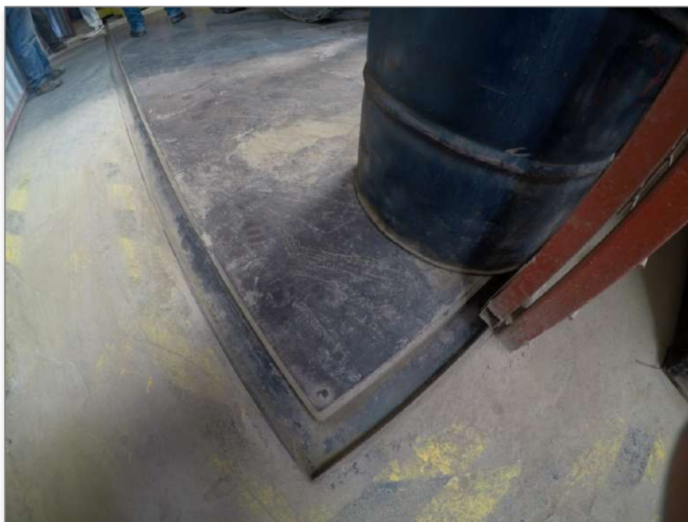
Figura 11. Canaletas para derrames.
