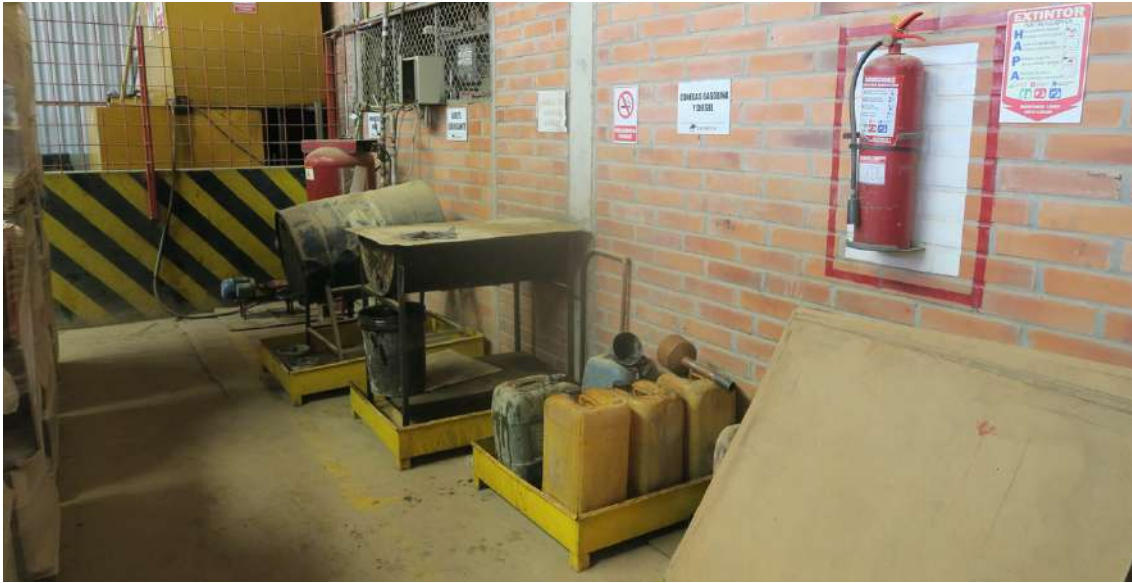
Anexo 47. Recipientes sobre cubetos para aislar los residuos peligrosos en caso de fuga.
