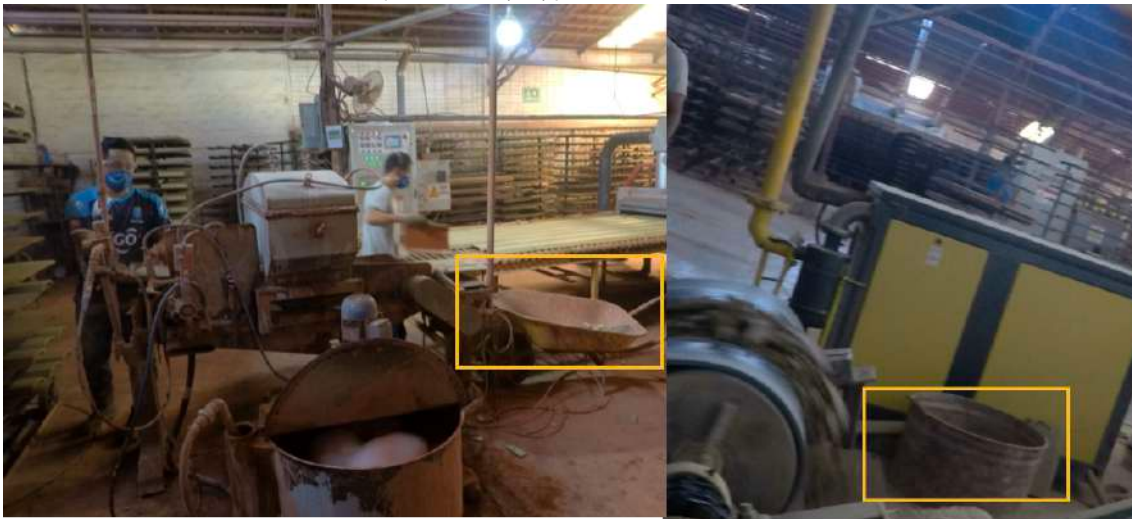
Anexo 44. Carretilla donde se almacenan momentáneamente los residuos del vidriado (izq.) que luego son llevados al tanque metálico (der) para su almacenamiento.
