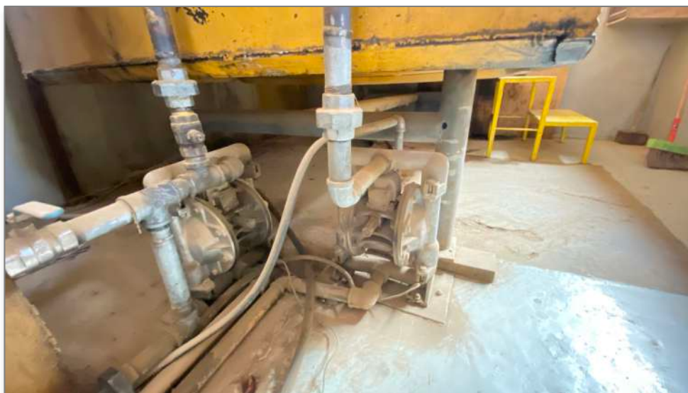
Figura 16. Bomba neumática de diafragma utilizada para el coprocesamiento.
