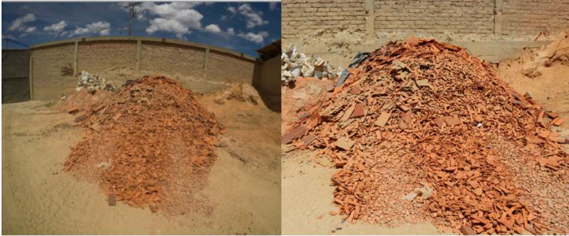
Anexo 40. Arcillas humedecidas para evitar la propagación de polvo.
