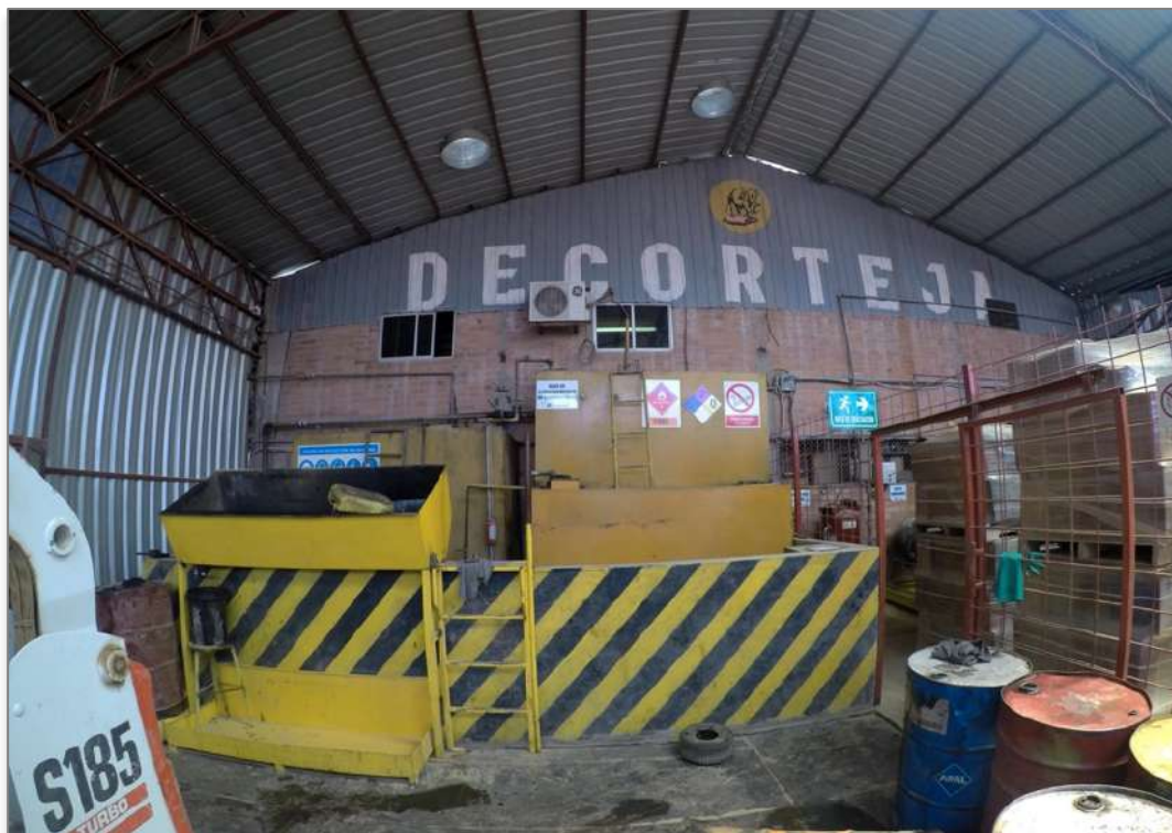
Anexo 35. Área de Almacenamiento y parte del sistema de coprocesamiento del Aceite Usado.
