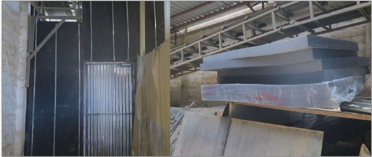
Figura 49. Zona de insonorización (izq.) y espumas acústicas (der).
