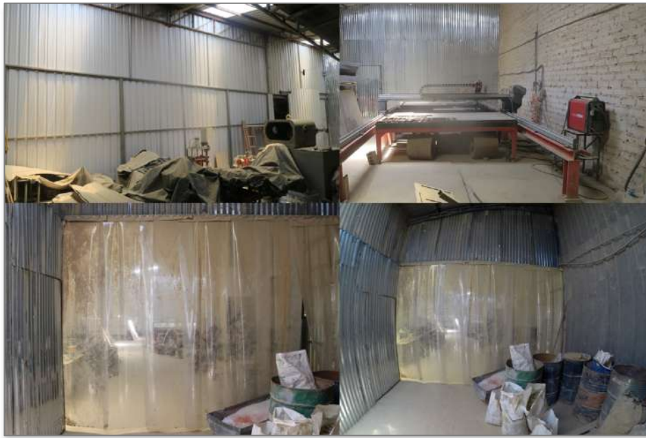
Figura 50. Zonas cubiertas con aluzinc y cortinas de plástico para evitar la expansión de material particulado.
